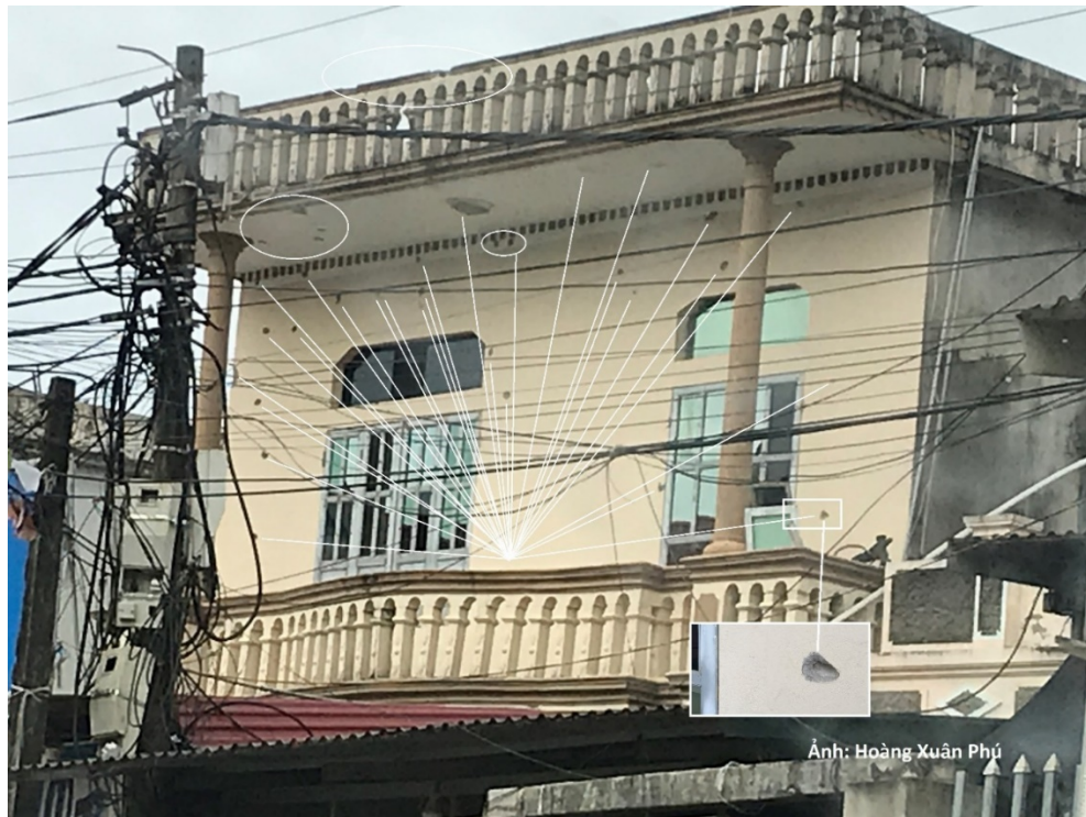
Ảnh 2.4: Một số vết đạn trên mặt tường phía trước nhà ông Lê Đình Hợi, được bắn từ đường thôn.
