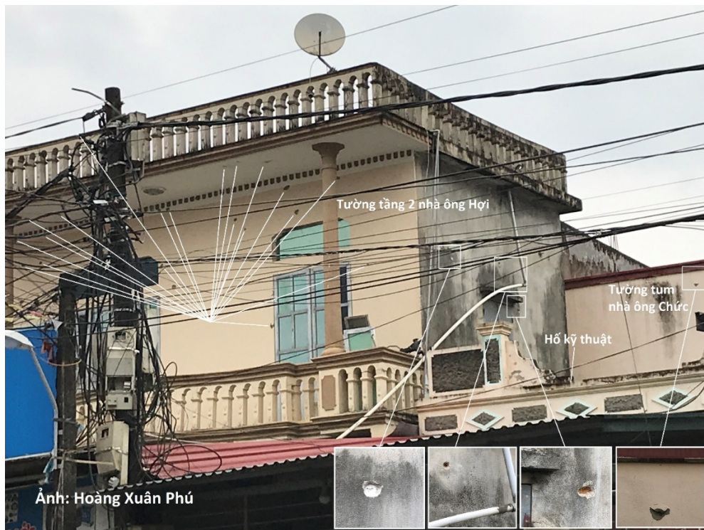
Ảnh 2.5: Một số vết đạn trên mặt tường phía trước và tường đầu hồi tầng 2 của nhà ông Lê Đình Hợi, cùng với vết đạn trên tường tum của nhà ông Lê Đình Chức, tất cả đều được bắn từ đường thôn.
