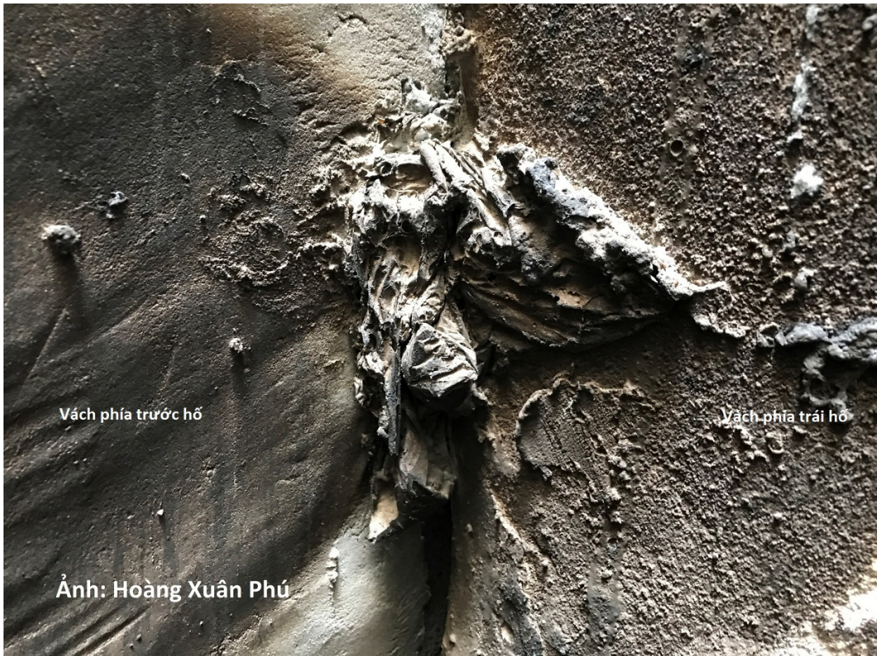
Ảnh 3.2: Dị vật cứng gắn chặt vào góc tiếp giáp giữa vách trước và vách trái của hố kỹ thuật.
