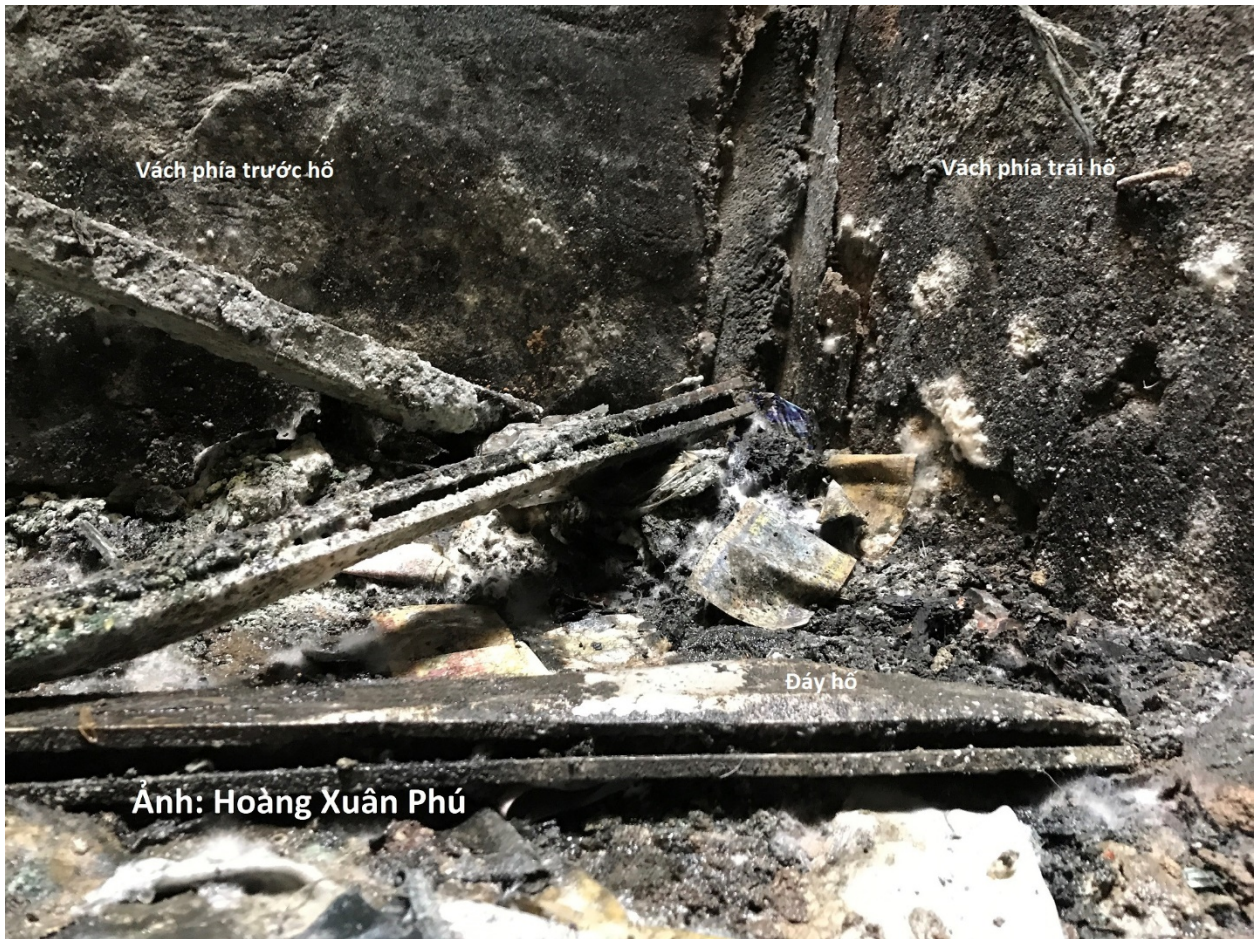
Ảnh 3.3: Dấu vết trên đáy hố kỹ thuật.
