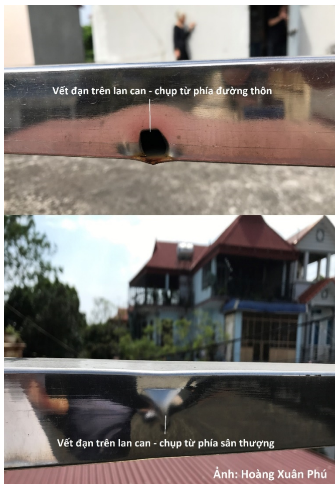
Ảnh 2.6: Vết đạn ở hai mặt của lan can inox trên sân thượng nhà cụ Lê Đình Kinh, được bắn từ đường thôn.
